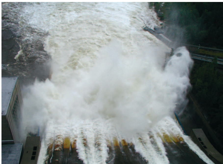
Obr. 5.6. Vývar pod bezpečnostním přelivem VD Orlík za povodně
