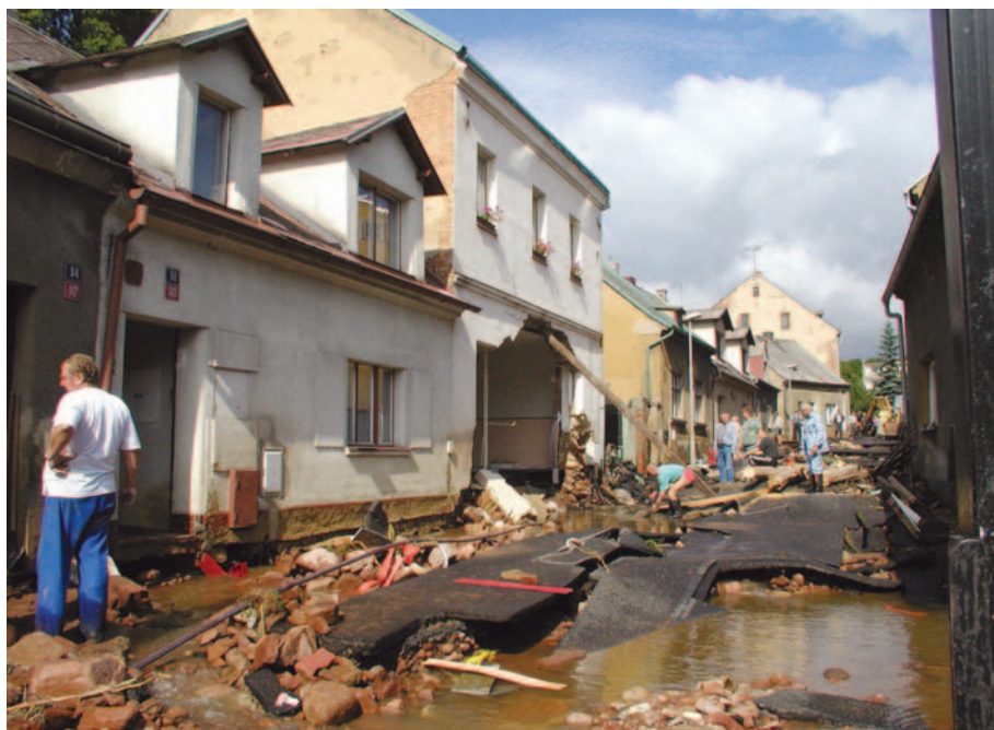
Obr. 8.5. Ulicí v Dubí se prohnala říčka Bystřice
