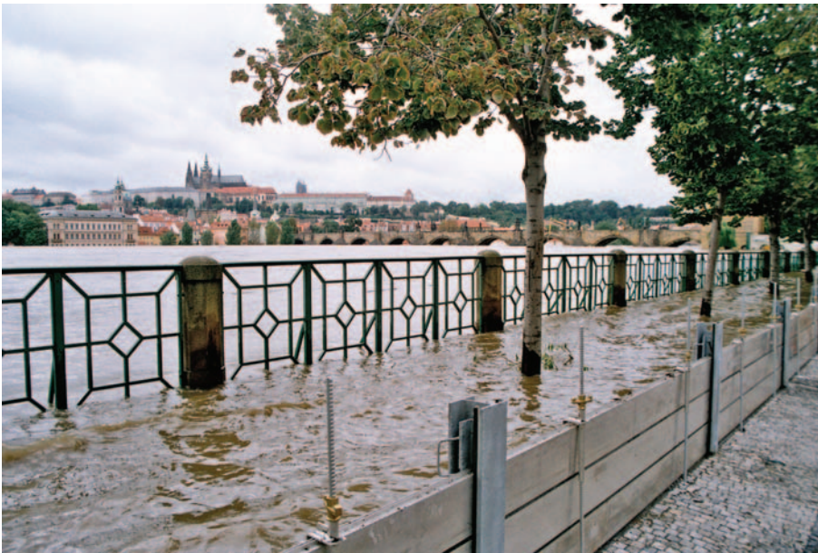
Mobilní protipovodňové stěny v centru Prahy
