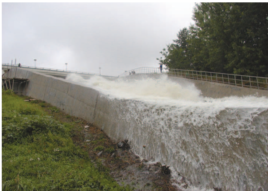
Obr. 5.3. Skluz pod bezpečnostním přelivem VD Římov na Malši při povodni
