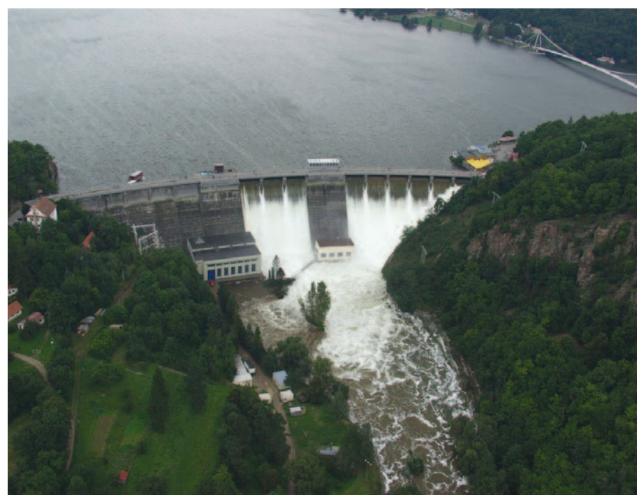
Obr. 5.9. Celkový pohled na VD Vranov na Dyji při povodni
