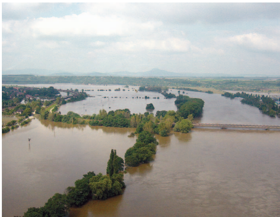
Obr. 7.3. Násep železnice tvoří bariéru odtoku vody nivou a zvyšuje hladinu nad touto překážkou (Labe ve Štětí)
