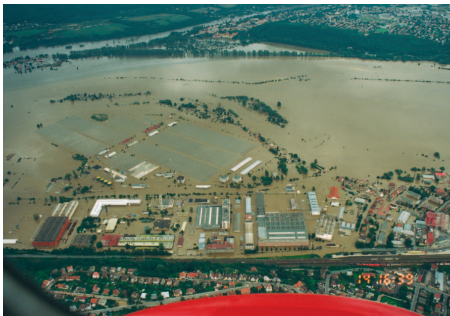
Obr. 7.5. Průmyslové objekty v nivě Berounky v Radotíně
